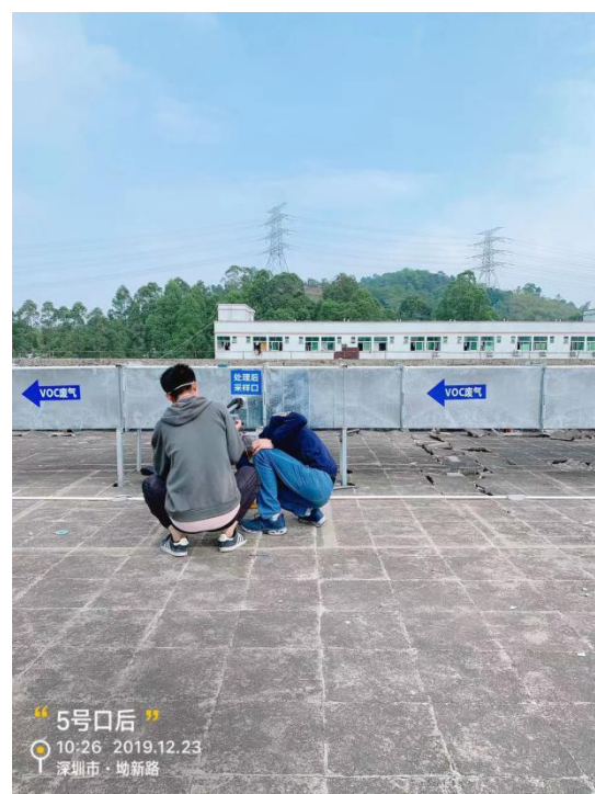
4 楼钉装废气处理后检测口
