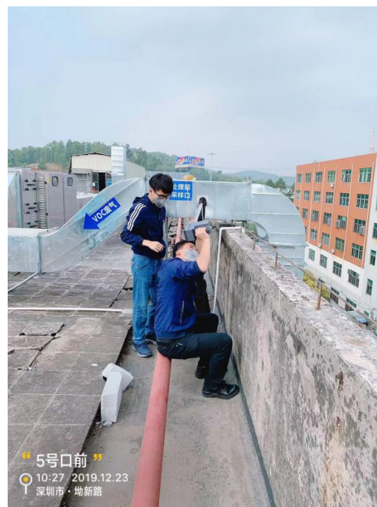
4 楼钉装废气处理前检测口
